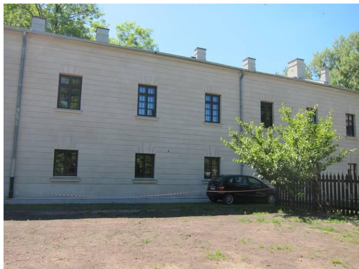
FOT. NR 1 Skrzydło zachodnie budynku
