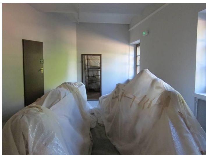
FOT. NR 2 Strop nad parterem – odcinkowy na belkach stalowych
