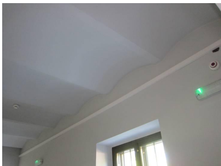
FOT. NR 5 Strop nad parterem – odcinkowy na belkach stalowych
