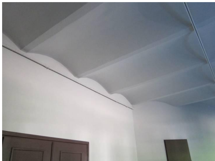
FOT. NR 4 Strop nad parterem – odcinkowy na belkach stalowych
