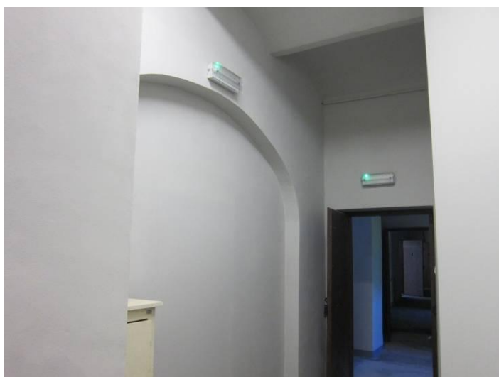
FOT. NR 8 Strop nad parterem – odcinkowy na belkach stalowych
