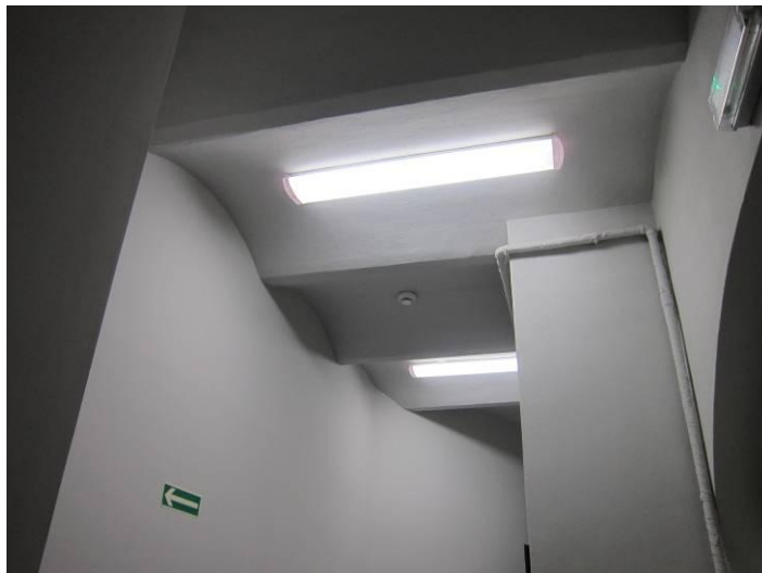
FOT. NR 7 Strop nad parterem – odcinkowy na belkach stalowych
