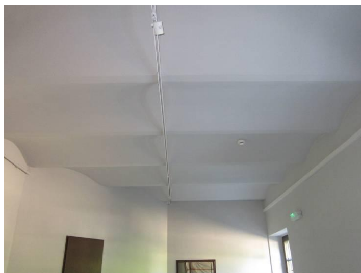
FOT. NR 3 Strop nad parterem – odcinkowy na belkach stalowych
