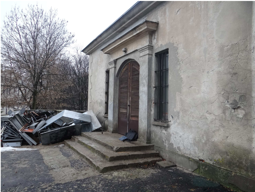
Wejście do pomieszczeń parteru na elewacji południowej
